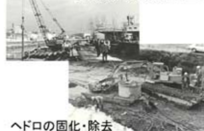
ヘドロの固化・除去
